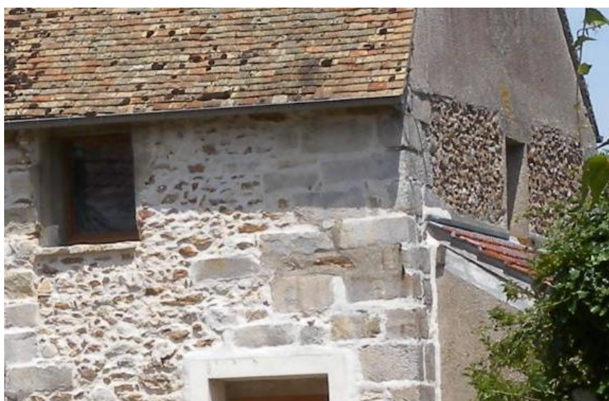
Photo 87 : On peut repérer quelques chaînes d'angles appareillées en harpage.
