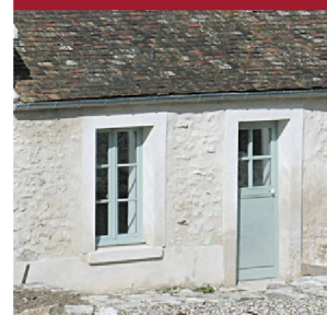
Décors de façade : bandes plates en plâtre
